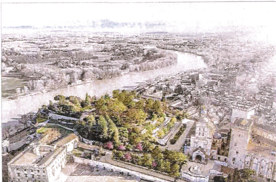
Berceau des Avignonnais, le Rocher des Doms est dans un état « lamentable ». Il doit faire l'objet sous peu d'une réhabilitation complète. Photo Saltus, Safran Conceptions Urbaines, Arpège Architecture et Botanique Jardins Paysages et Product'Air
